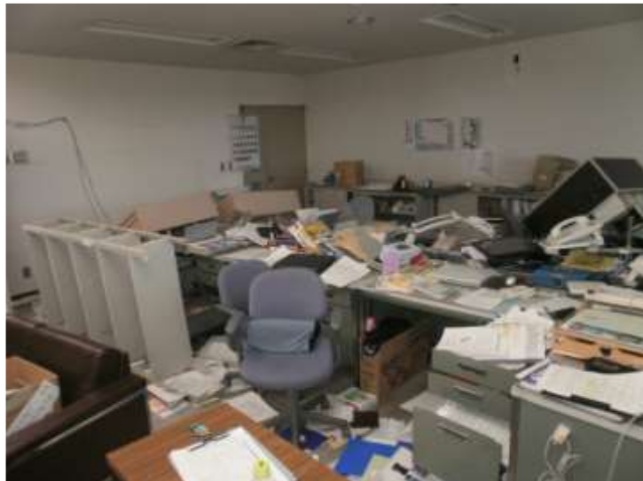
地震直後の役場庁舎3階事務室
