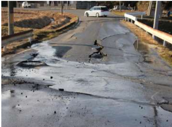
地震直後の道路の様子
