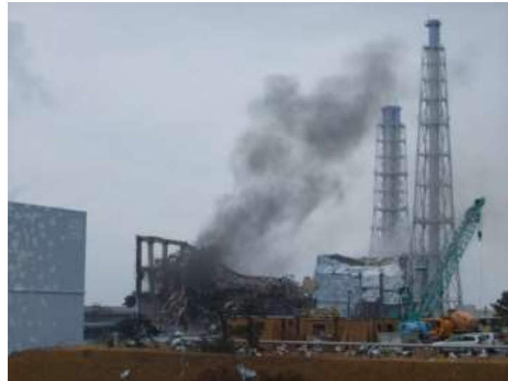
損傷した福島第一原子力発電所3号機 (東京電力(株)より提供)
