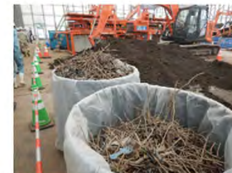
除去土壌から分別した異物（手前） 分別後の土壌（奥）
