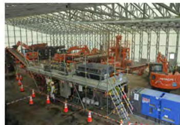
再生資材化施設の内部の様子
