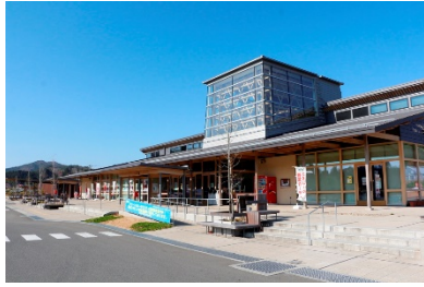
道の駅までい館
