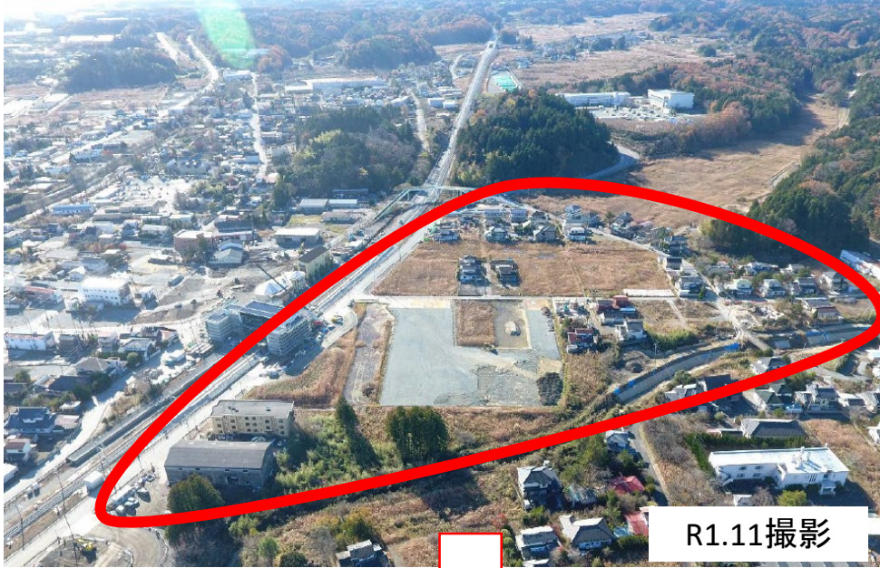
双葉駅西側地区（住む拠点）の造成状況
