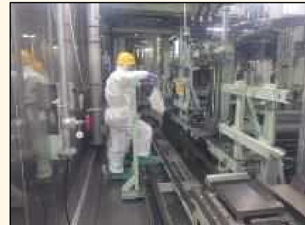
遮蔽フード内での作業
