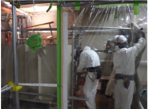
グリーンハウス設置
