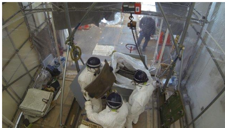
切断品を専用鉄箱に収納
