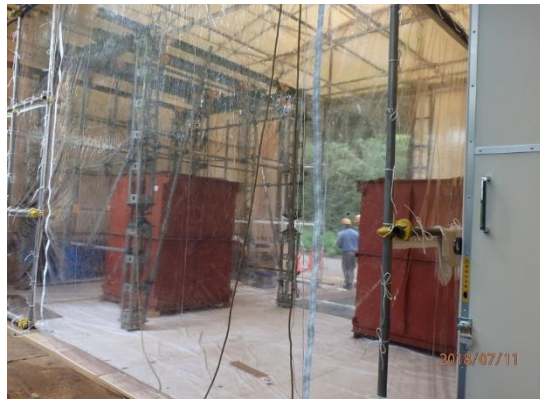
保管容器切断
