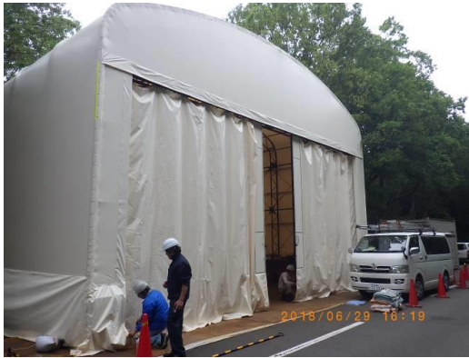
解体作業用屋外テント
