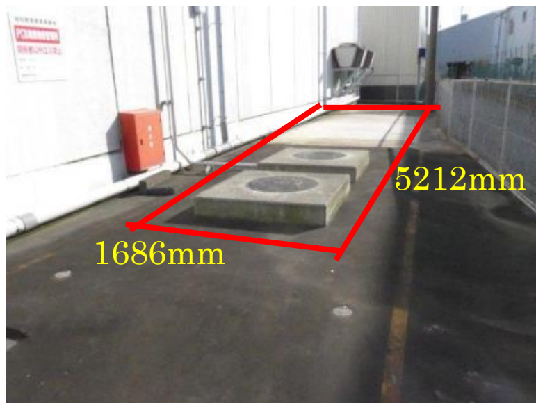
地下に大型タンクが埋設
