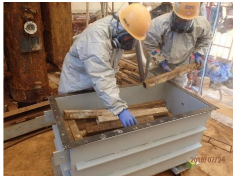
切断品を密閉容器に収納し搬出
