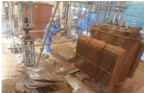
劣化・漏洩変圧器の切断作業
