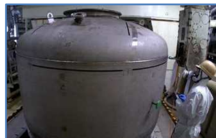
大型五面加工機による解体作業
