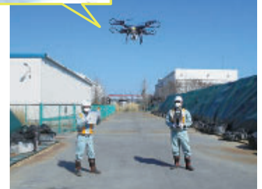
ドローンを活用した点検の様子
