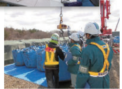
工事監督支援の様子
