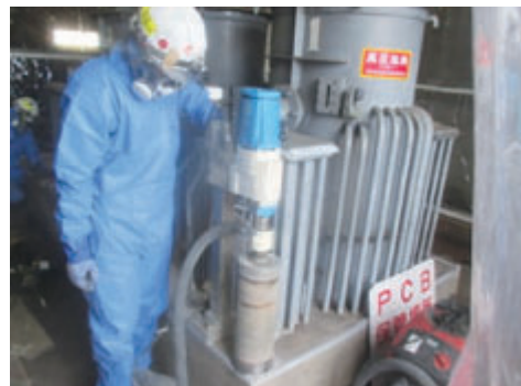
汚染コンクリート除去作業
