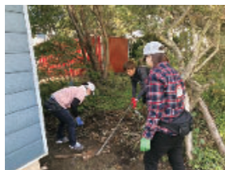
被災地支援 瓦礫片付け
