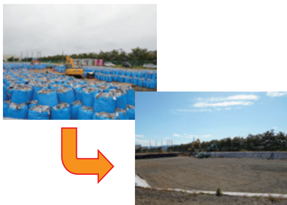
【仮置場の様子(搬出中→搬出後)】
