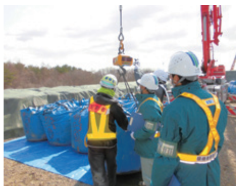
仮置場からの積み出し工事の様子
