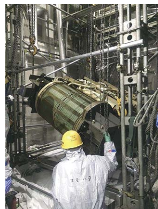
超大型トランス等現場解体(コア分解)
