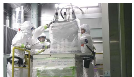
漏洩コンデンサの取り出し
