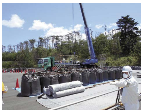
保管場における工事監督支援
