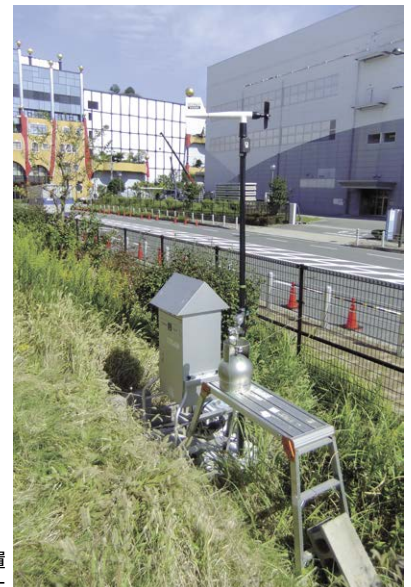
周辺環境(大気)測定装置 風向・風速計とエアサンプラー
