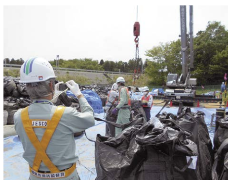
仮置場からの積み出し工事の様子
