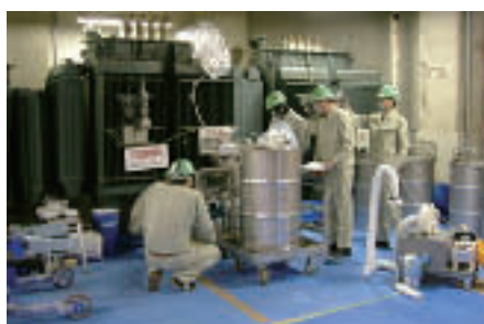
現地抜油作業
