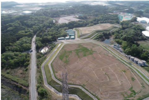
■ 中間貯蔵施設に搬入された除去土壌を安全に貯蔵する土壌貯蔵施設
