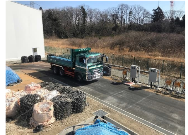
促進載荷試験:ダンプトラック走行状況
