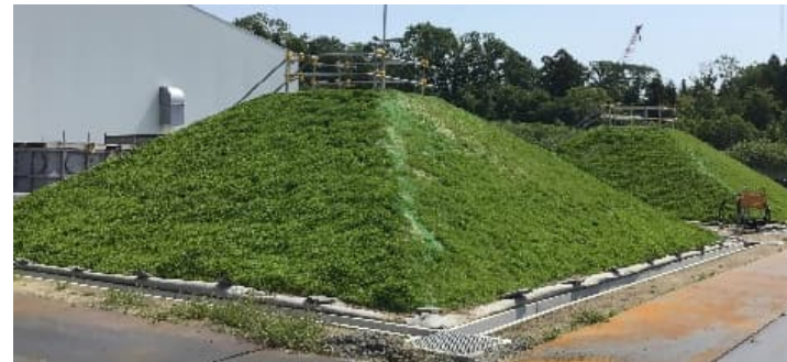
供用中 (法面は植生で保護)
