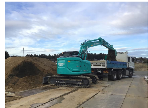
盛土材搬出(盛土解体)
