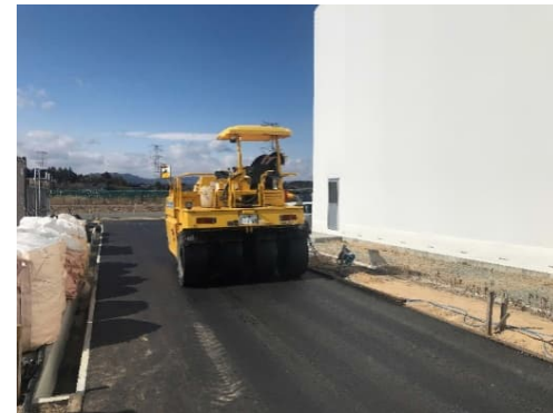
アスファルト舗装道路の構築
