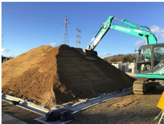
盛土・覆土施工
