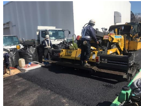
アスファルト舗装道路の構築
