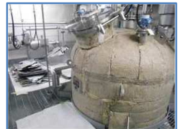
保温材撤去前のタンク
