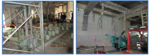
〈 受入室 着手後 〉 (現状)
