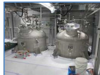
保温材撤去後のタンク
