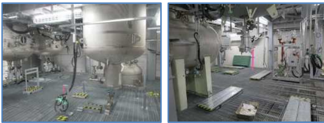
〈 配管等を撤去後のプラント設備の状況 〉 (現状)
