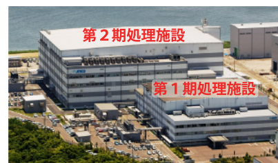
北九州 PCB 廃棄物処理施設
