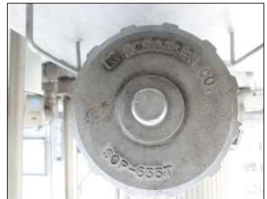
払い出し口 65Aカップラ (株)工技研究所 SOP-655-T
