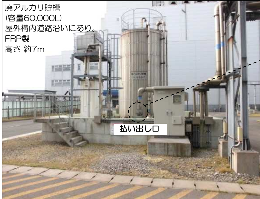
払い出し口 65Aカップラ (株)工技研究所 SOP-655-T
