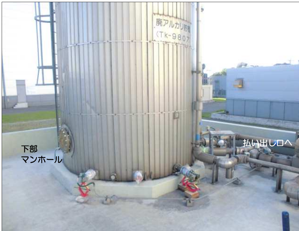
払い出し口 65Aカップラ (株)工技研究所 SOP-655-T
