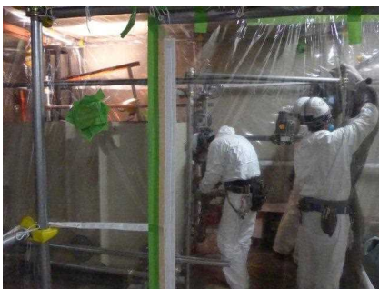
グリーンハウス設置
