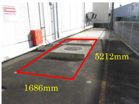
地下に大型タンクが埋設
