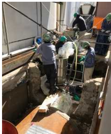
タンク上部からの垂直抜油
