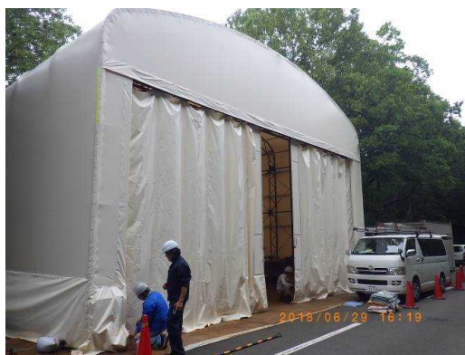
解体作業用屋外テント
