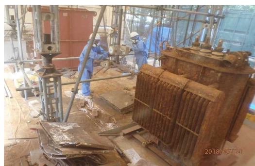
劣化・漏洩変圧器の切断作業
