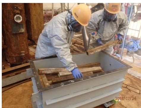
切断品を密閉容器に収納し搬出
