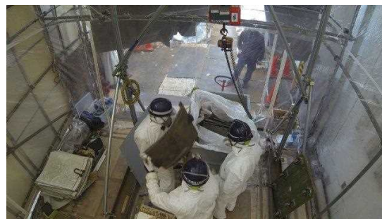
切断品を専用鉄箱に収納
