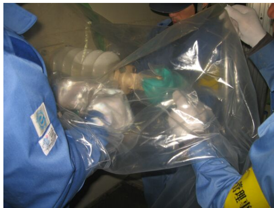
図ー6 グローブバッグを使用した付属品取外し作業
