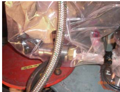
図－10 グローブバッグによる密閉措置
