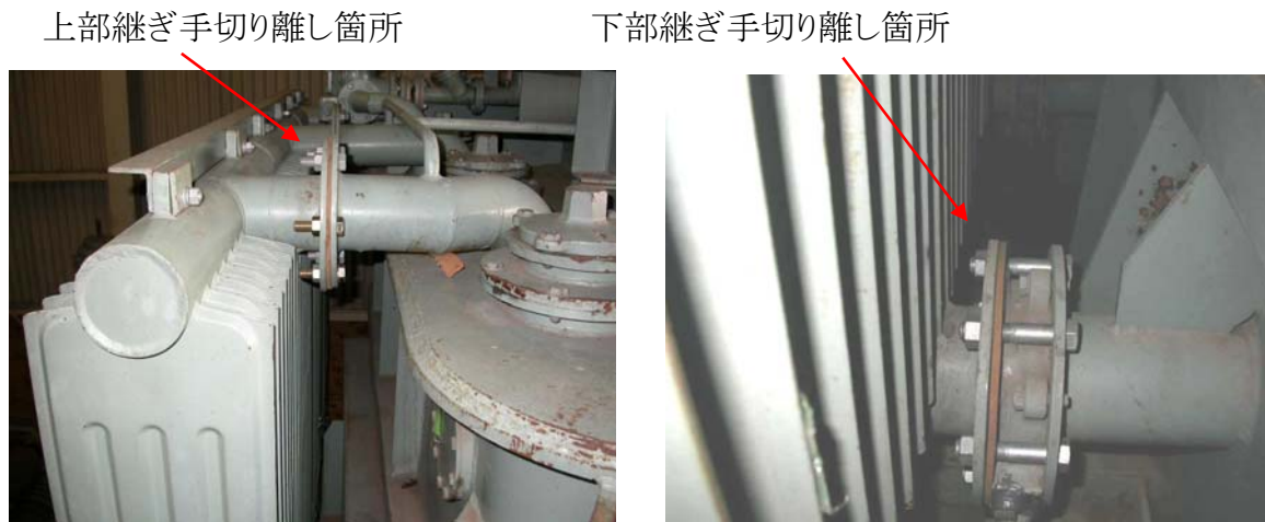
図ー5 フランジ接続付属品の代表例としての放熱器
