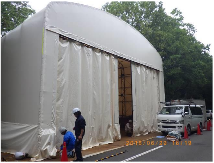
解体作業用屋外テント
