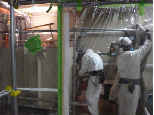
グリーンハウス設置
