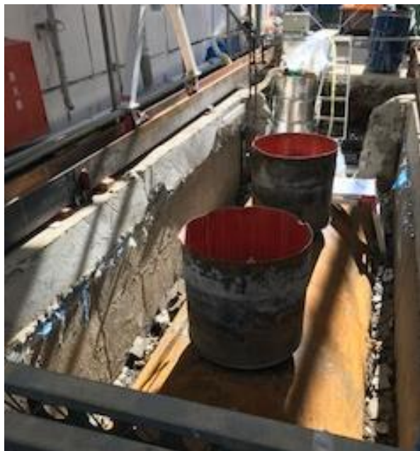
タンク掘出し
