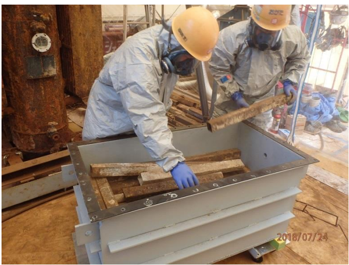
切断品を密閉容器に収納し搬出
