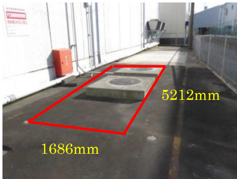
地下に大型タンクが埋設
