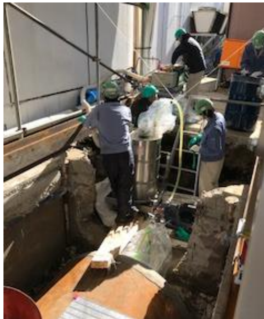
タンク上部からの垂直抜油
