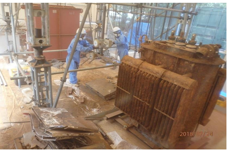
劣化・漏洩変圧器の切断作業
