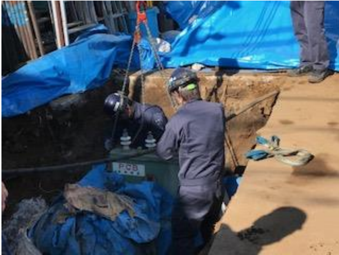
コンデンサー取出し作業
