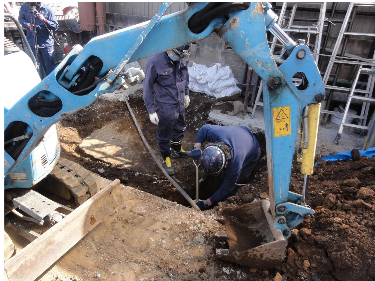
重機を使った掘り出し作業
