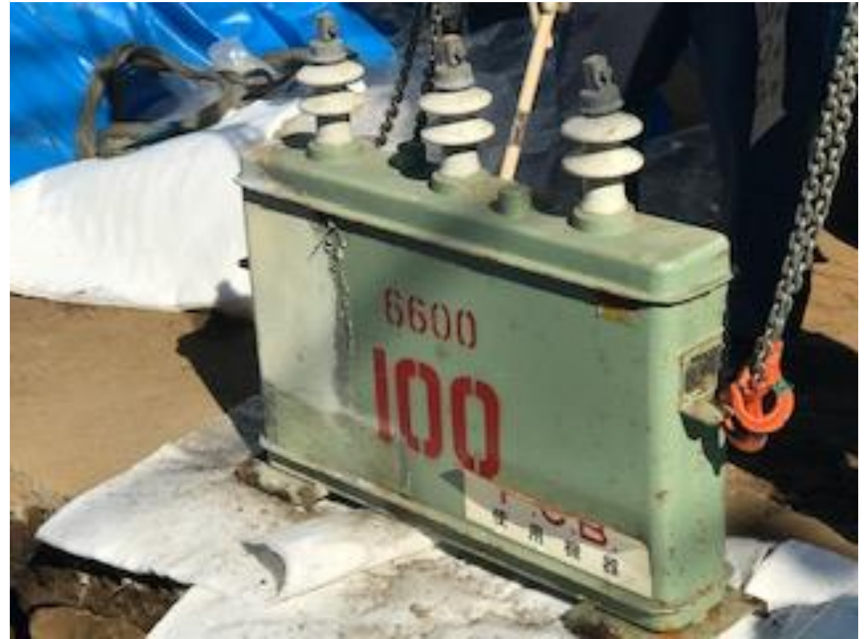
掘り出したコンデンサー ・100kVA 92kg ・漏洩、破損なし
