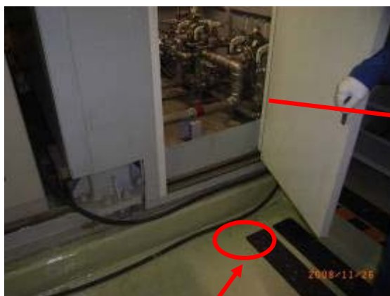
写真5 流出場所：オイルパンを超えて2～3ℓが作業場に流出
