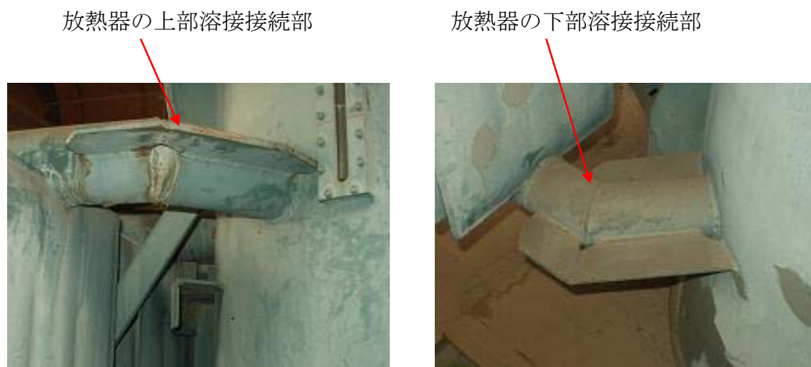
図 8 溶接接続付属品の例
