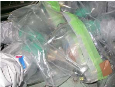
図7-2 グローブバッグを使用した付属品取外し作業
