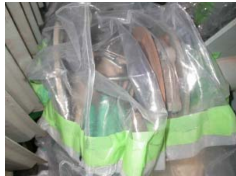
図7-2 グローブバッグを使用した付属品取外し作業
