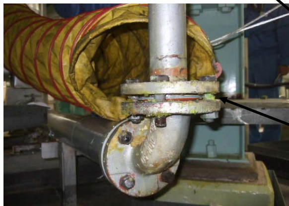
結露防止のカバー撤去後
