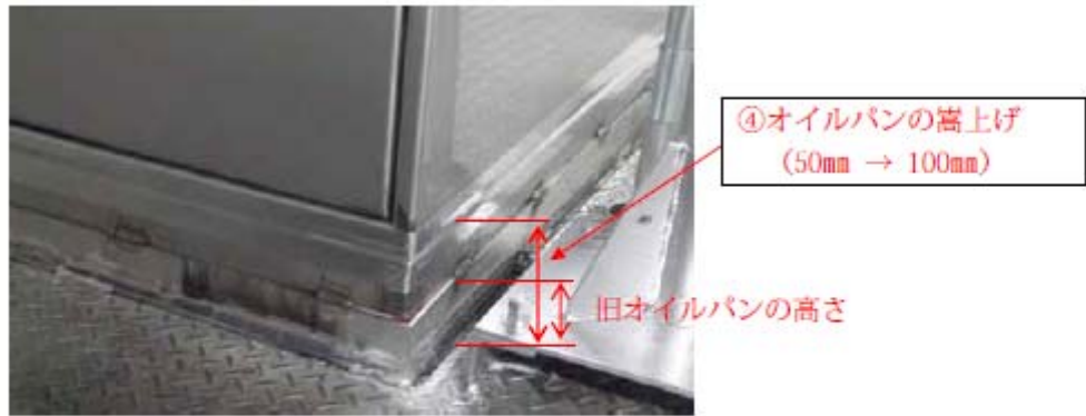
写真2 オイルパンの改造
