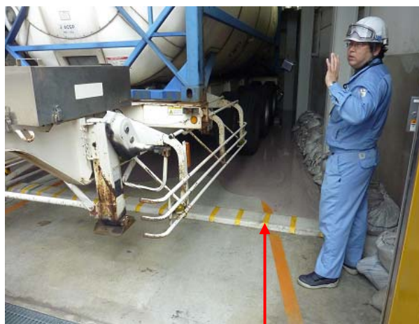
防油堤(漏洩したSD剤はこの内側(堤の向こう側)に留まっていた。)
