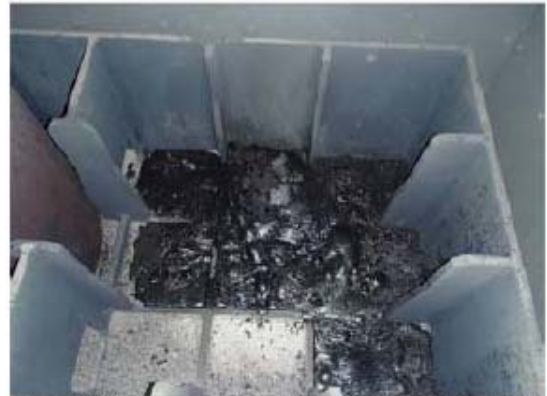
②スラグ受容器パンをスラグ冷却室まで移動した後の状態(10/30 15:50頃)
