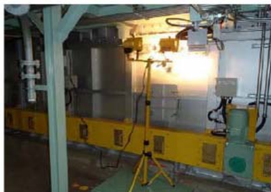
⑤覗き窓に投光器を設置した状態(10/31 2系)
