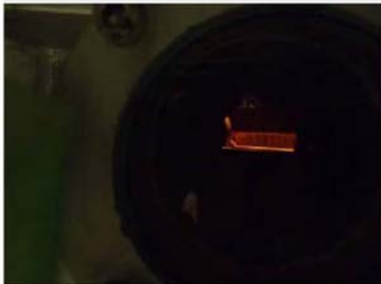
③通常操業時(2系)覗き窓より内部を見た状態
