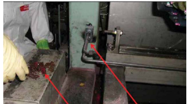
素子くず(柱の裏にあったもの) 溶接箇所
