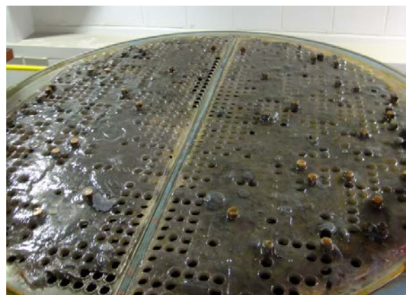
図 21 不良チューブの補修状況
