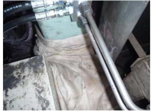
図6 溶接作業時の養生(再現)
