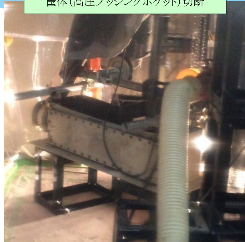
筐体(高圧ブッシングポケット)切断
