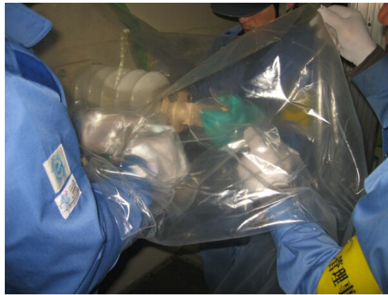
図-6 グローブバッグを使用した付属品取外し作業
