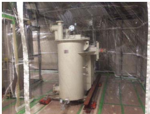
図－12 保管事業場に設置されたグリーンハウス内での解体作業
