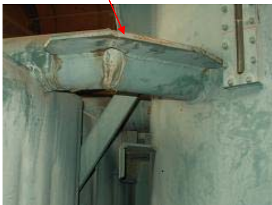
図-7 溶接接続付属品の例
