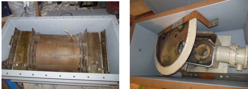
図－11 切断・解体され運搬容器に収納されたトランス
