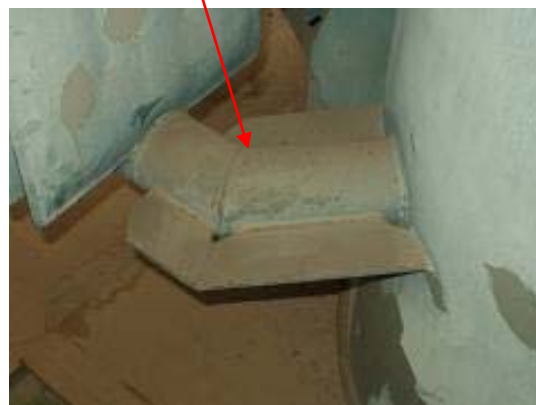
図-7 溶接接続付属品の例
