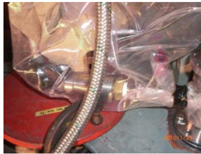
図-10 グローブバッグによる密閉措置
