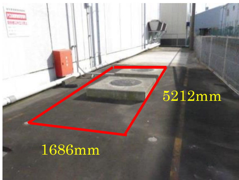
地下に大型タンクが埋設
