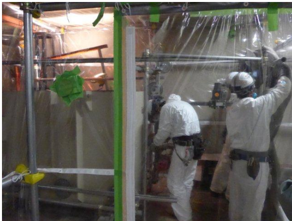
グリーンハウス設置
