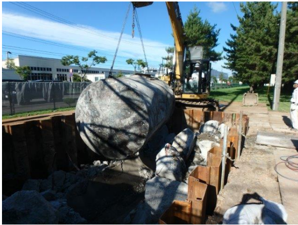
タンク掘出し
