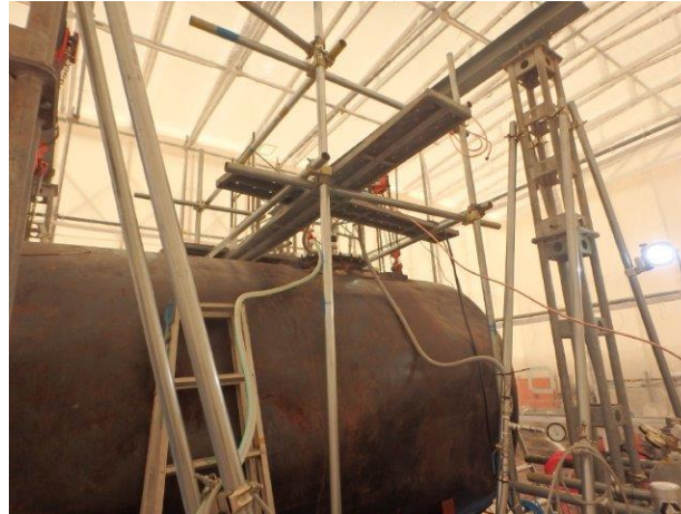
タンク上部からの垂直抜油
