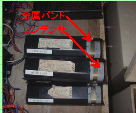
①コンデンサ露出型 タイプ
