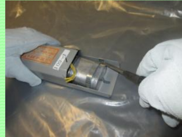
コンデンサの 取り外し作業
