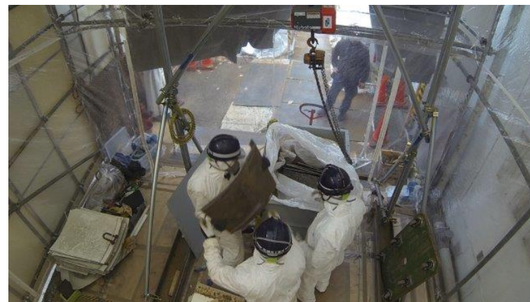
切断品を専用鉄箱に収納
