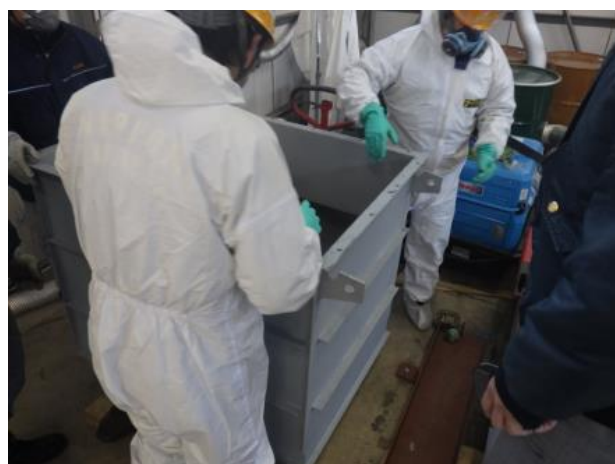
切断品を密閉容器に収納
