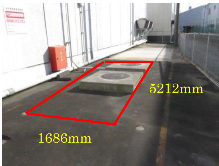
地下に大型タンクが埋設
