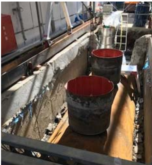
タンク掘出し
