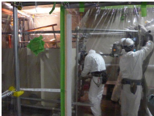
グリーンハウス設置
