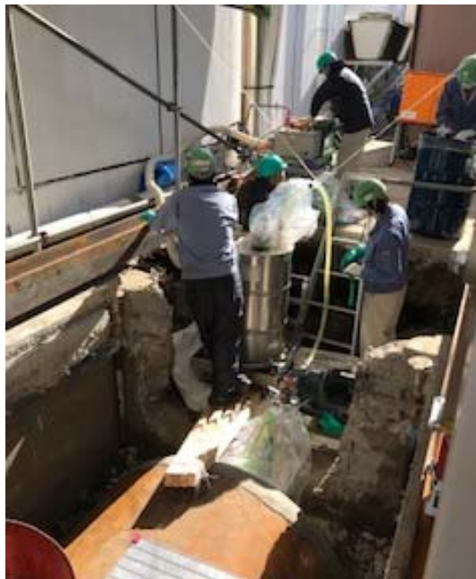
タンク上部からの垂直抜油
