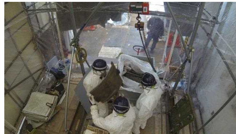
切断品を専用鉄箱に収納
