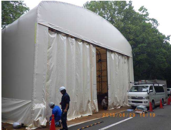
解体作業用屋外テント
