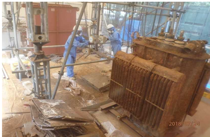
劣化・漏洩変圧器の切断作業
