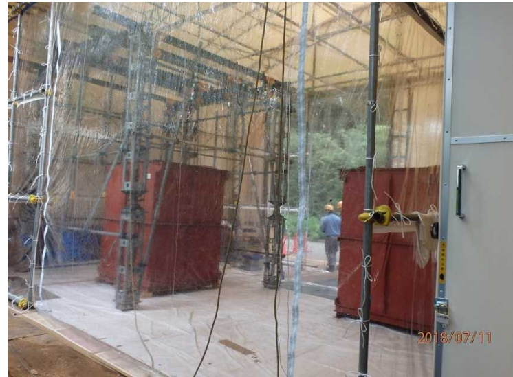
保管容器切断
