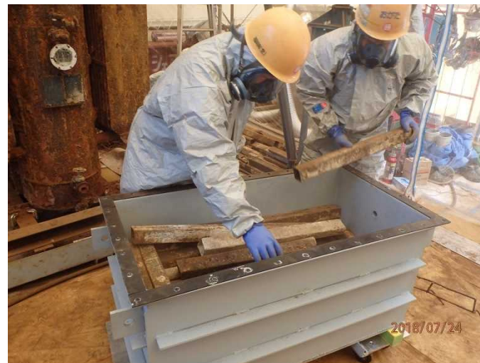
切断品を密閉容器に収納し搬出
