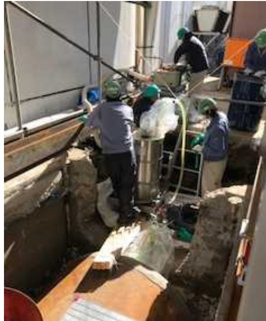
タンク上部からの垂直抜油
