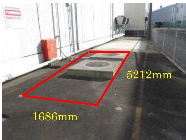
地下に大型タンクが埋設
