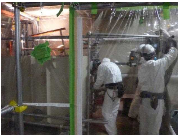
グリーンハウス設置
