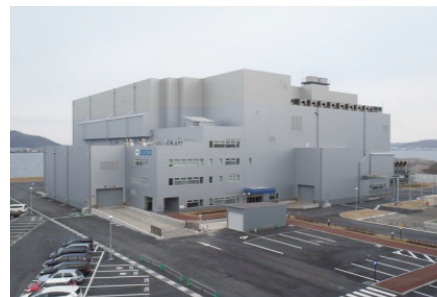
当初施設 4 F より増設施設工事現場を見たところ
