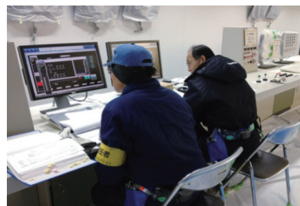
試運転状況（中央制御室）
