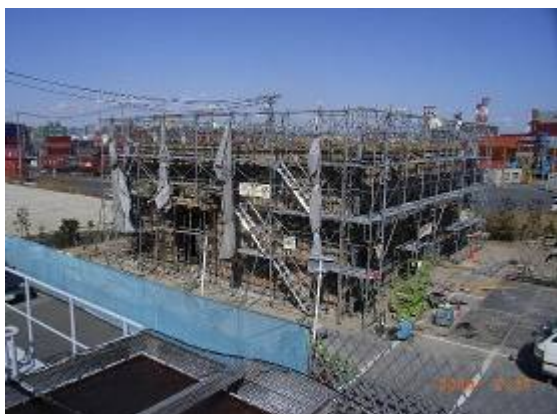
写真3 倉庫工事状況(平成20年2月25日撮影)
