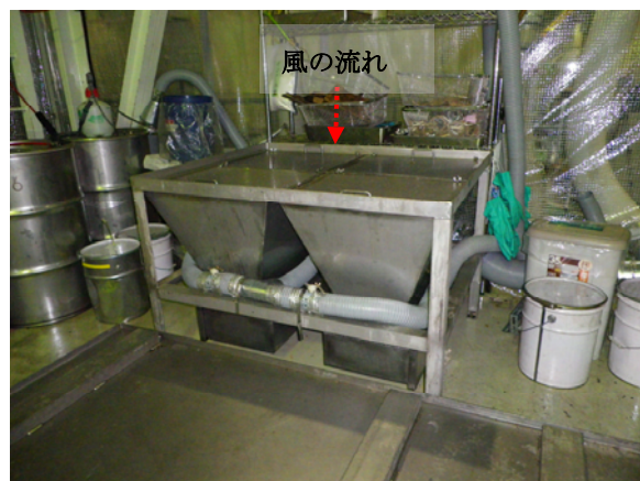
写真8 作業台（格子状）下から排気する
