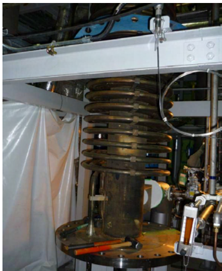
写真2 らせん式冷却器(外枠撤去後)
