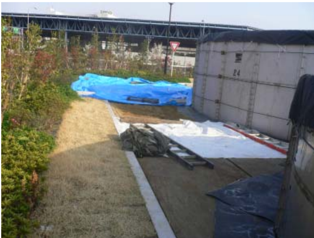
1 . オーバーフローした仮設タンク(右手前)と芝生側 (3月28日午後5時30分)
