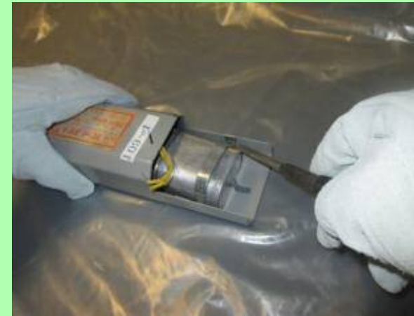
コンデンサの 取り外し作業
