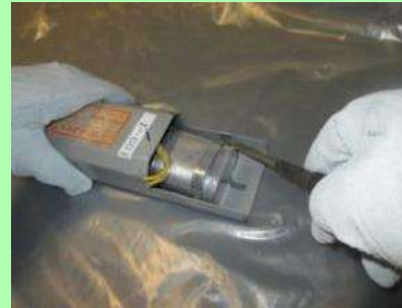
コンデンサの 取り外し作業
