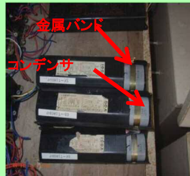
②コンデンサ露出型 タイプ (金属バンド式)
