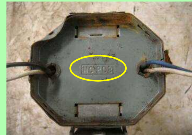
刻印による情報 (「NO PCB」表示→不使用)
