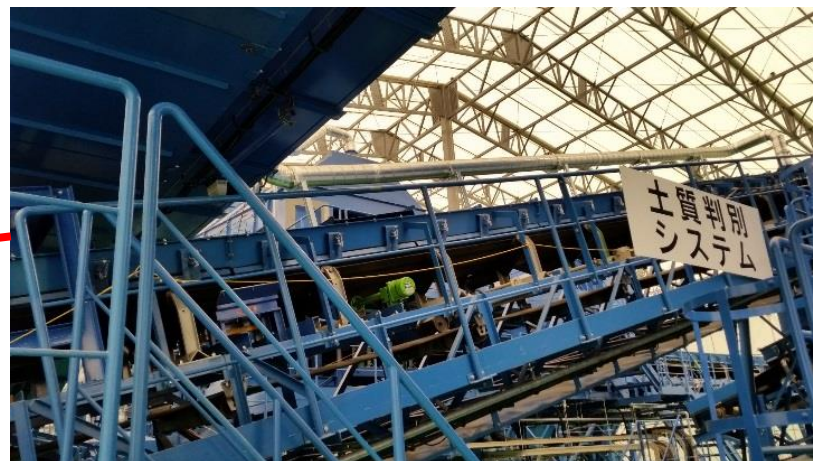
大熊3工区 土質判別システム
