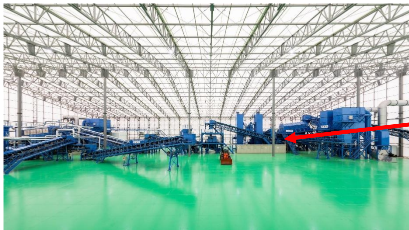
大熊3工区 受入分別施設
