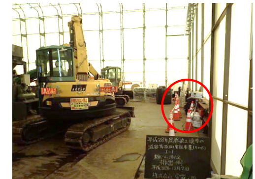
粉じん測定 (排出側)
