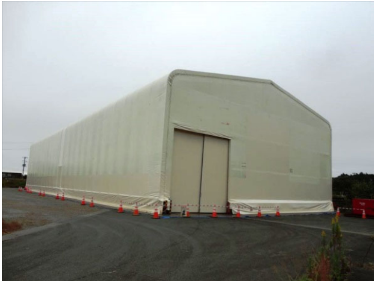
現地試験場所に設置したテント (L50m×W20m×H11m)
