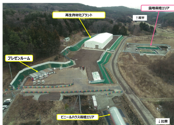
工事全景（環境省HPより）
