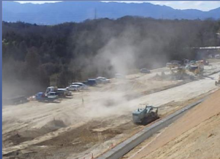
発塵状況(土木工事)
