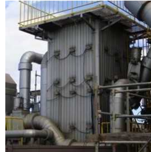
(C) No.1 バグフィルタ (BF) [溶融飛灰を捕集]
