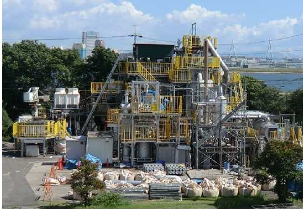
(B) 溶融炉本体 [Csを分離]
