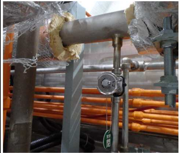
保温材取り外し後の排水ポンプ吐出配管
