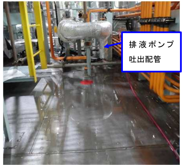
保温材取り外し後の排水ポンプ吐出配管
