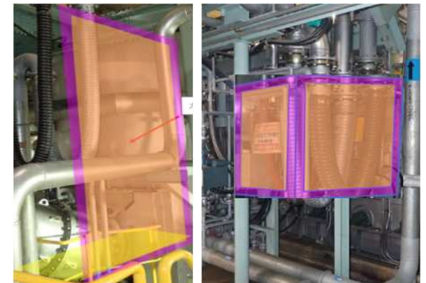
[飛散防止カバーの設置]
