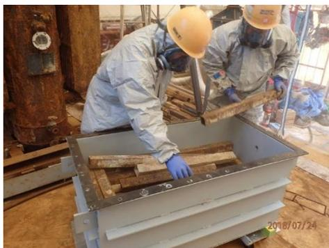
切断品を密閉容器に収納し搬出
