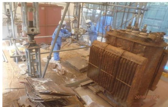
劣化・漏洩変圧器の切断作業
