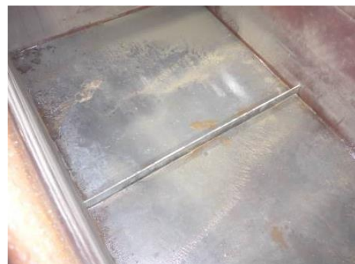
写真 3 シャワーリング後
