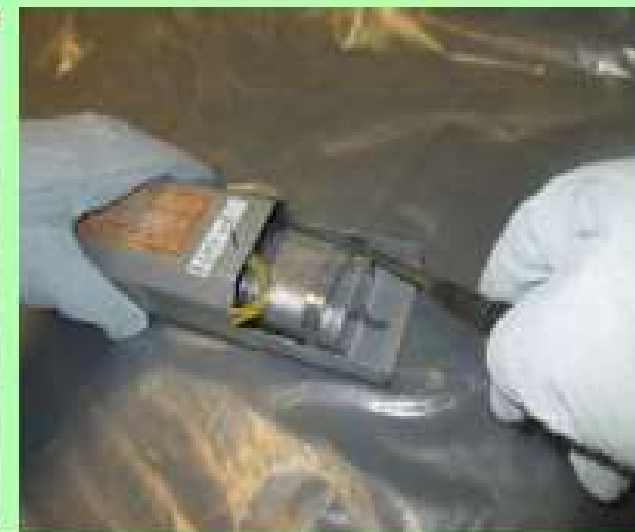
コンデンサの 取り外し作業
