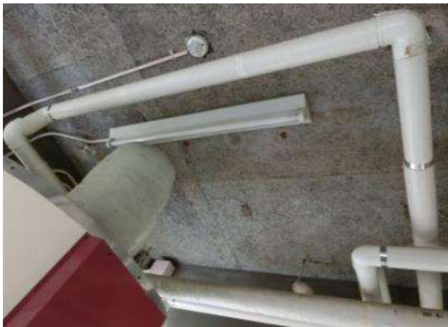
ボイラー上部
