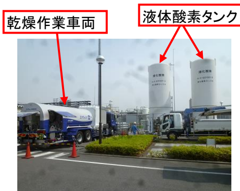
液体酸素タンク乾燥作業の様子
