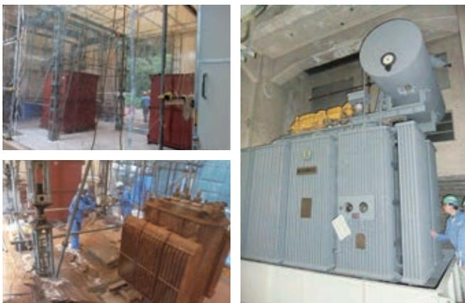
屋外テント設置による漏洩トランス解体作業 超大型トランスの例
