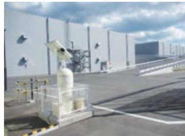
放射線モニタリング装置の設置状況
