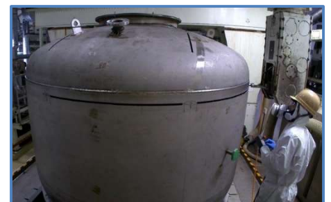
大型五面加工機による解体作業
