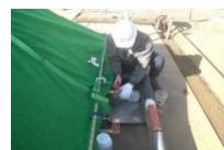
写真-5 浸出水採取
